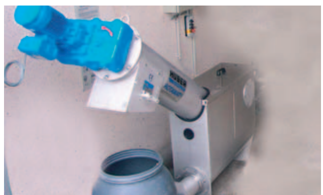
ROTAMAT® Micro Strainer Ro 9 Ec montado en contenedor
