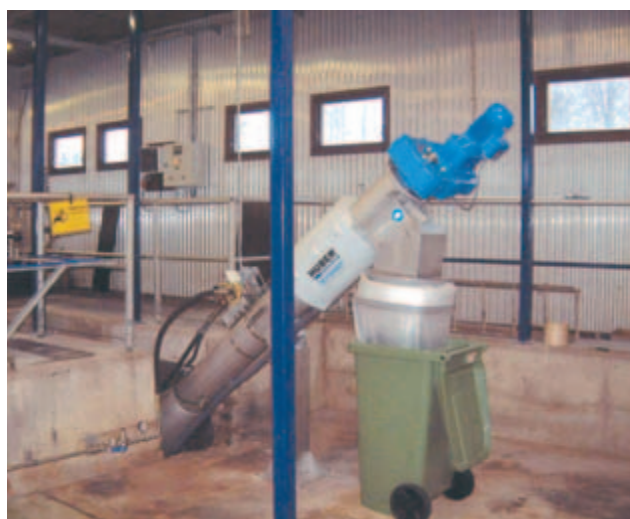
ROTAMAT® Micro Strainer tamaño 700 instalado en canal
