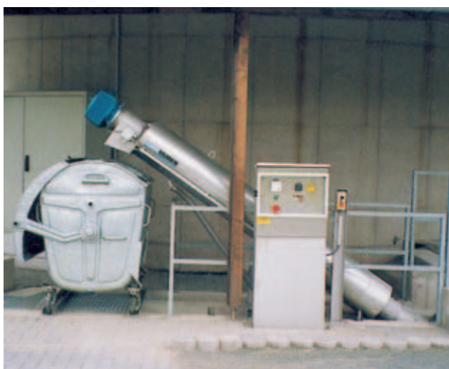
Instalación estándar de un ROTAMAT® Micro Strainer
