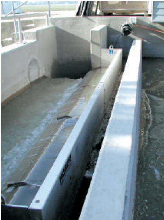
ROTAMAT® RoK 2, colocado detrás de deflector, en funcionamiento
