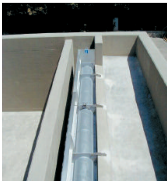
El tamiz de aliviadero ROTAMAT® RoK colocado detrás de deflector
