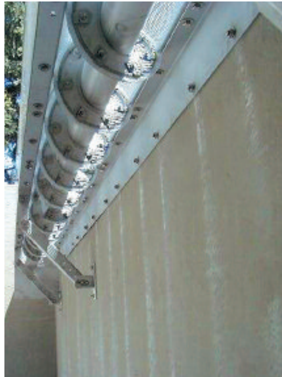
Vista del tamiz de aliviadero ROTAMAT® RoK 2 por el lado de entrada del agua
