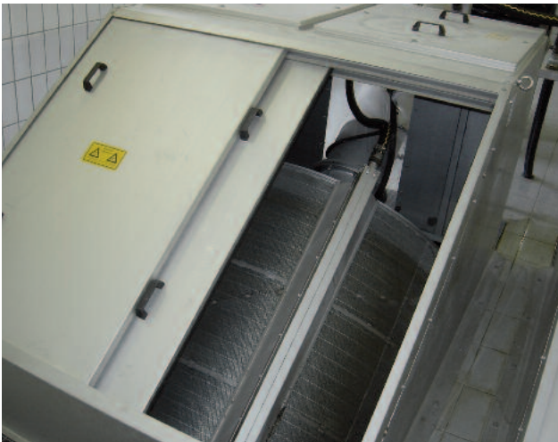
Tamiz ROTAMAT® Ro 2 instalado en un canal con una cubierta de acero inoxidable removible, de 600 a 3000 en tamaño
