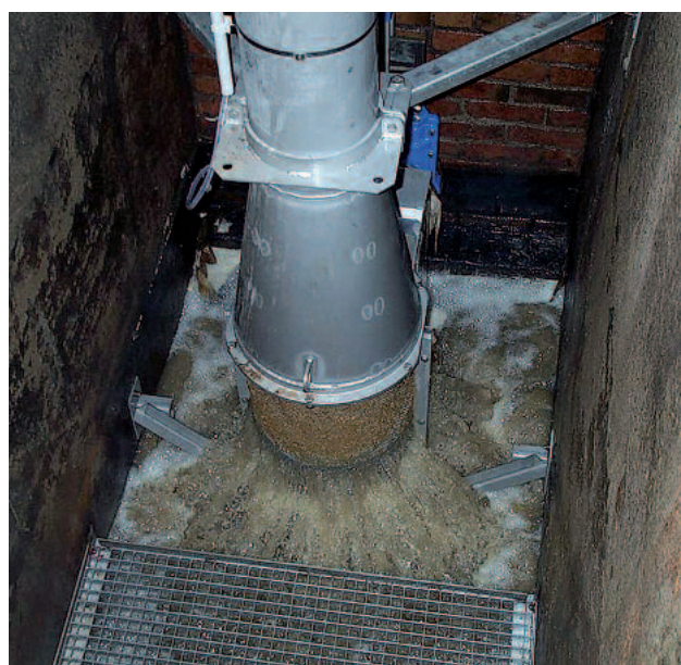
Tamiz ROTAMAT® RoK 4 para pozos de bombeo en operación
