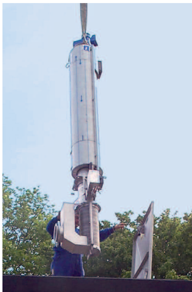
Tamiz ROTAMAT® RoK 4 siendo transportado por una grúa dentro de una estación de bombeo
