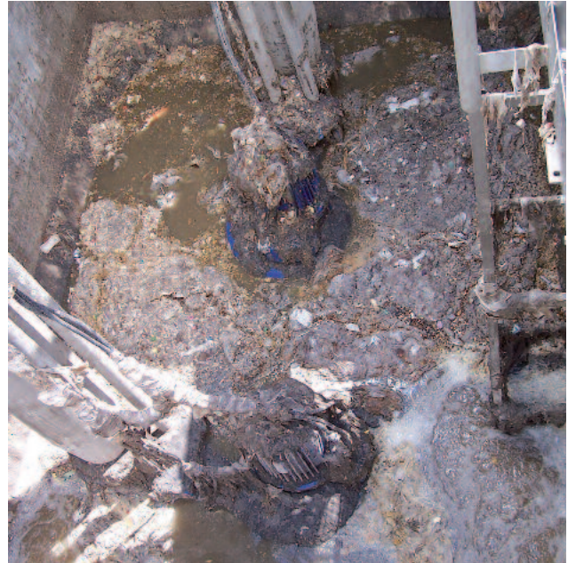
Bombas trabadas a causa de los sólidos presentes en el medio.
