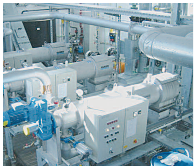
Tamizado de Lodo de fermentación (industrial)
