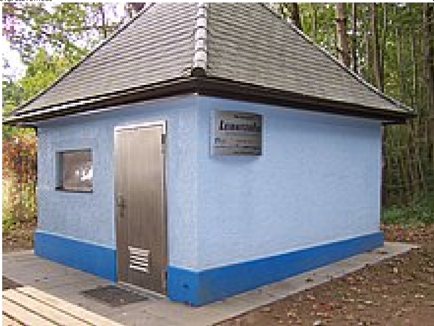
Leibnitzerfeld Wasserversorgung GmbH - pumping station Kaindorf 1
