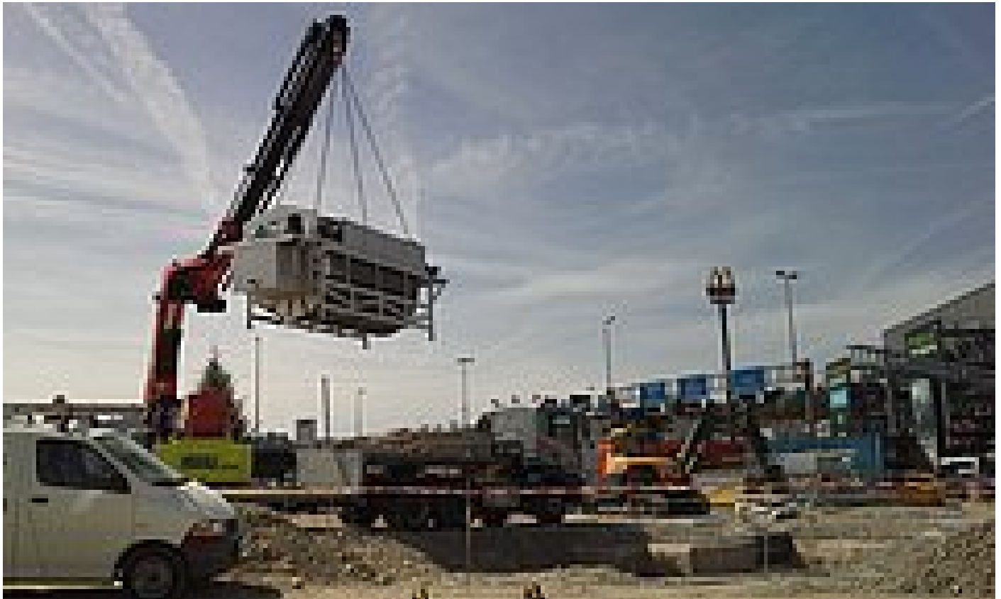
Montaje de la SABA de Seetalplatz, subterránea en una rotonda
