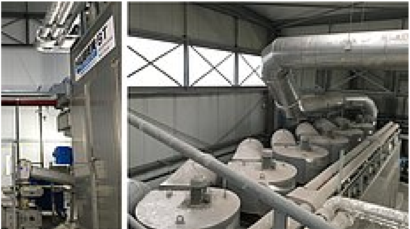
Primer secador de cinta BT 22 de HUBER en servicio regular
