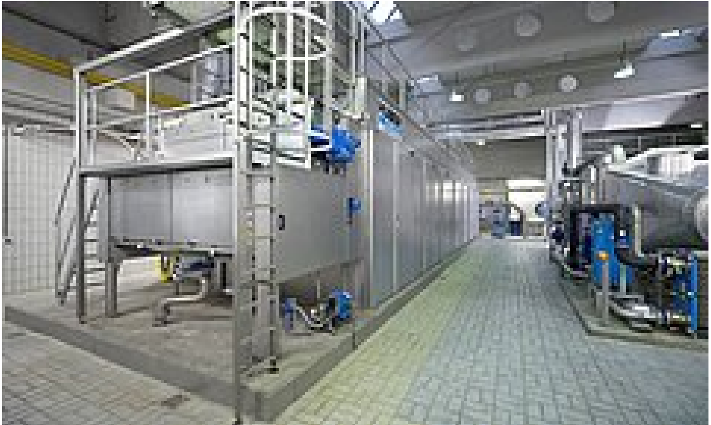
Figura 1: Secador de cinta HUBER BT 16 con etapa de condensación, secador de dos zonas de temperatura con 90 °C y 140 °C de temperatura de salida
