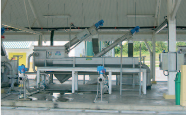
Planta de tamizado de fangos con desarenador y clasificador de arenas ROTAMAT® Ro 3.3
