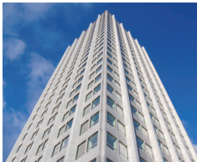
Climatización del edificio de oficinas Torre Winterthur mediante el sistema HUBER ThermWin®.
