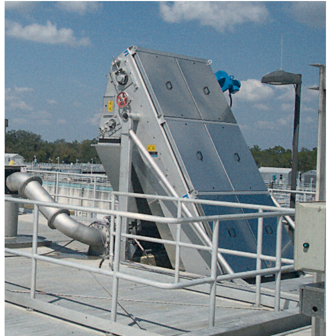
Tamiz completamente cerrado, sin olor y con cubiertas fáciles de remover
