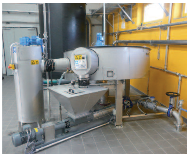
Espesador de disco ROTAMAT® RoS 2S diseñado para 35 m³/h
