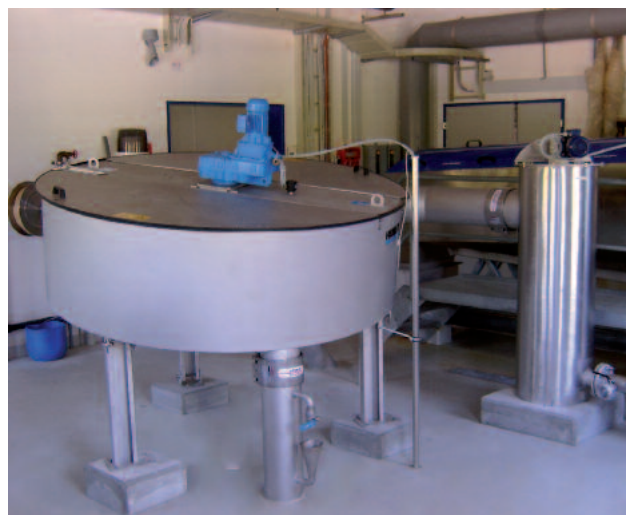
Instalación estacionaria del espesador de disco ROTAMAT® RoS 2S tamaño 2
